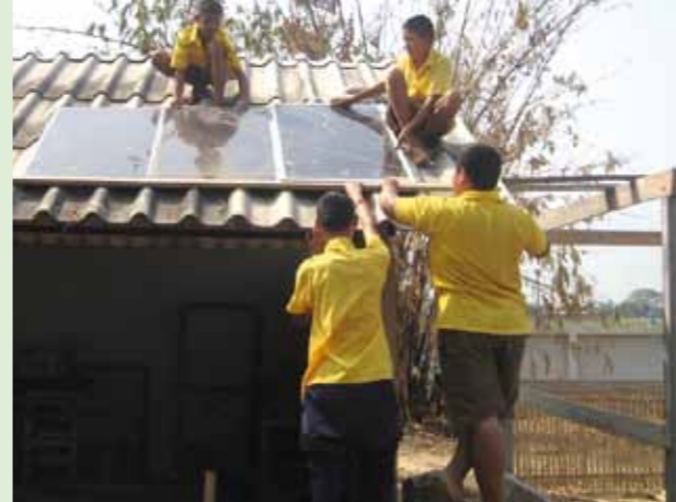
ช่วยกันติดตั้งแผงโซลาร์เซลล์
